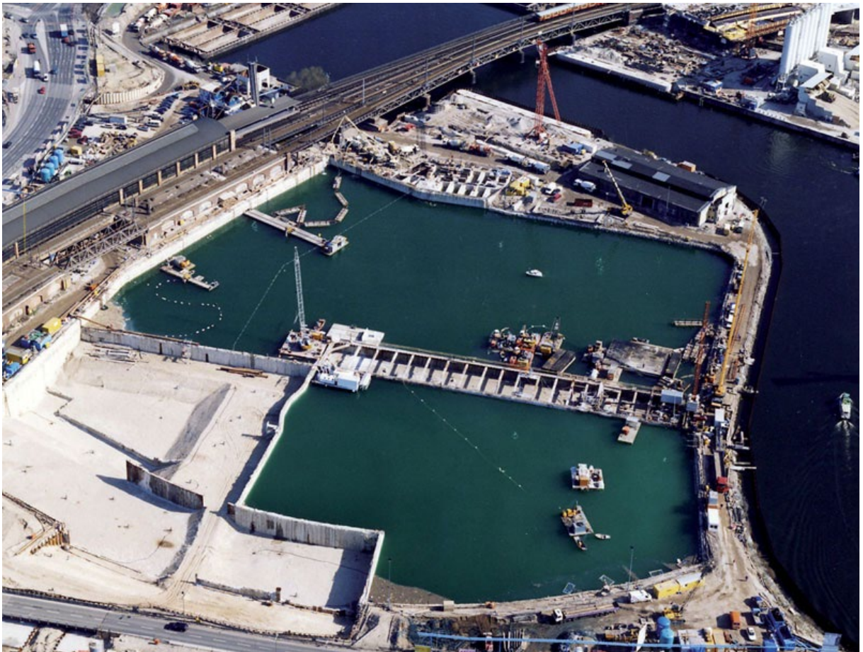
Hình 4: CO 2 dùng cho trung hòa tại công trường xây dựng Nhà ga chính Berlin, trước đây là Nhà ga Lehrter.
