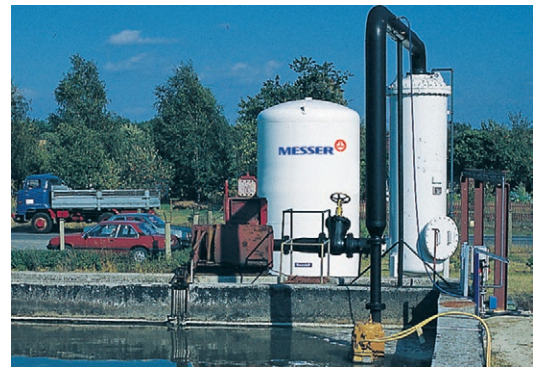
Hình 1: Kỹ thuật cấp oxy tinh khiết được Messer phát triển: Ống phân phối khí (bên trái), đầu phun (giữa), hệ thống cấp oxy (bên phải).
