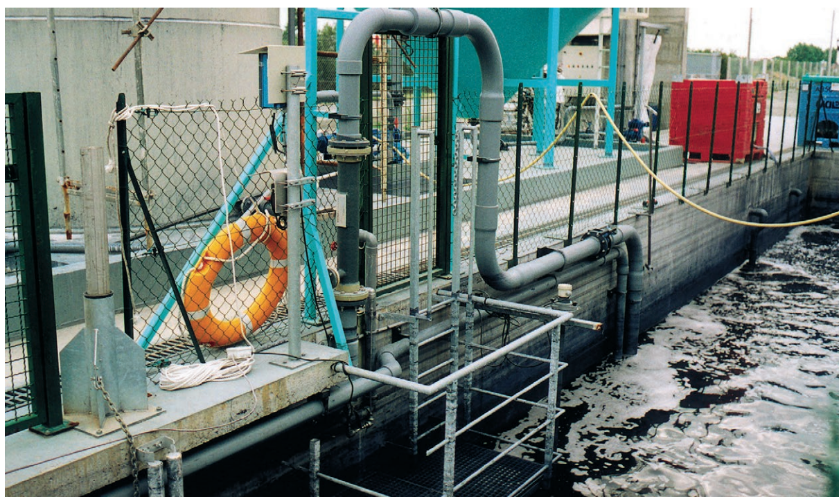
Hình 7: Trung hòa nước thải kiềm của ngành dệt nhuộm bằng CO 2 .
