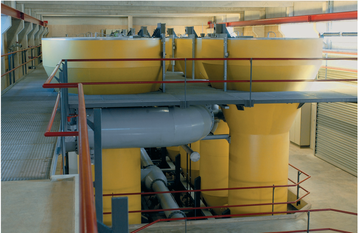
Hình 5: Quá trình khử carbon nhanh trong lớp tầng sôi với carbon dioxide phun ở đầu ra của thiết bị phản ứng
