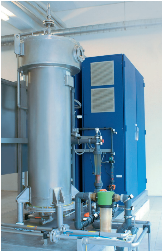
Hình 10: Lắp đặt máy ozone hiện đại nạp liệu 3 kg oxy tinh khiết mỗi giờ.
