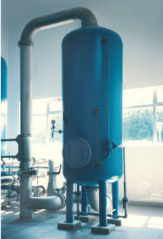
Hình 9: Quá trình phun oxy bằng máy phát oxy để oxy hoá sắt và mangan
